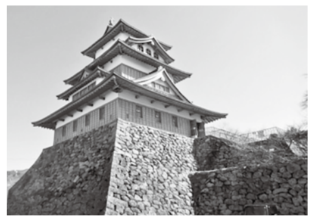
▲野面積みという工法で造られている。地盤が軟弱の為、沈下しないように大木で組んだ筏の上に石垣を積んでいる。
