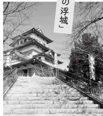
▲野面積みという工法で造られている。地盤が軟弱の為、沈下しないように大木で組んだ筏の上に石垣を積んでいる。
